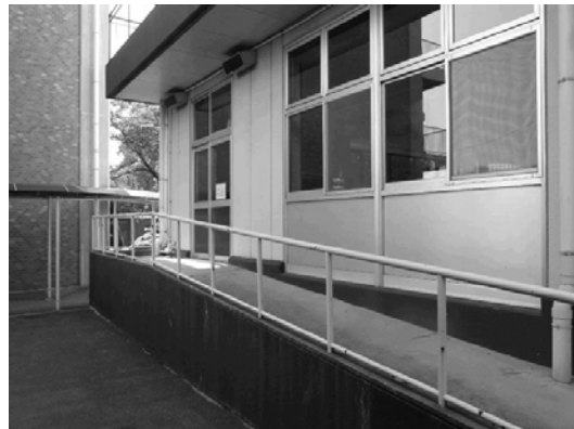
食堂横のスロープ（入口段差の補修）
