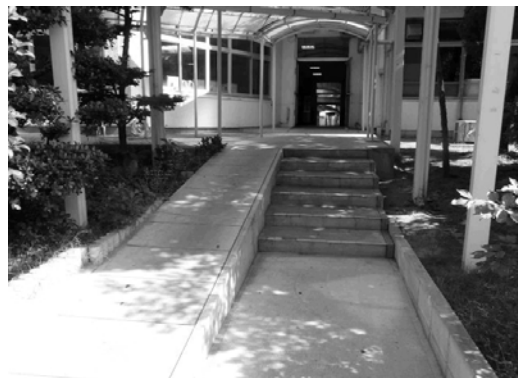
7号館入口段差の補修
